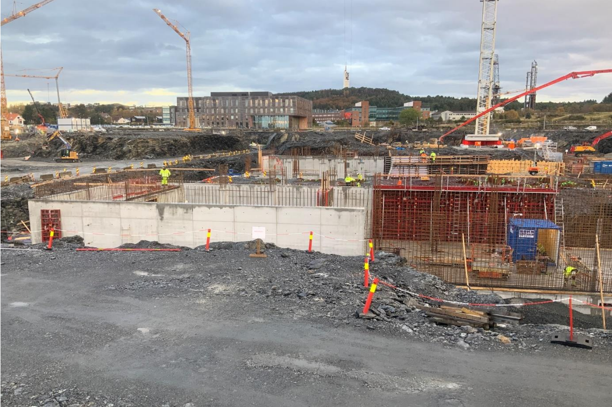
Støping av kjelleretasje
